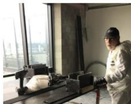
Aplicarea adezivului epoxidic pe laminate
