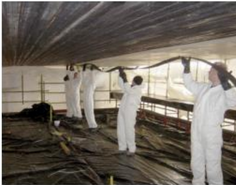
Poziționarea laminatelor
